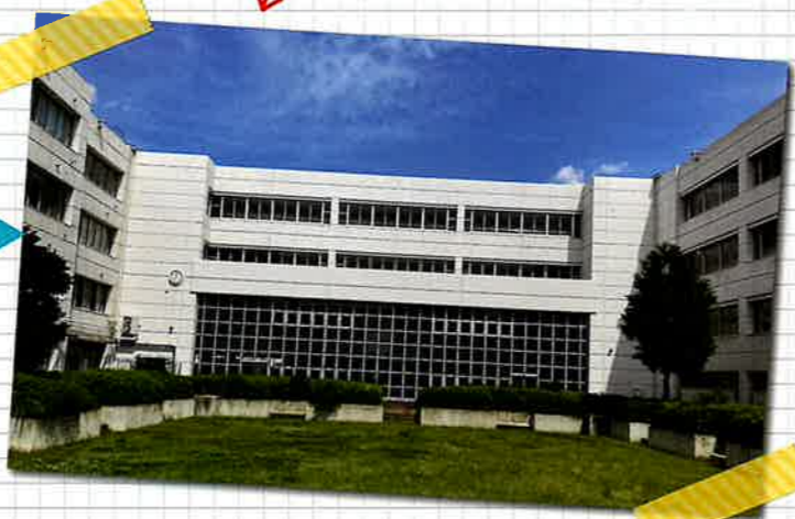
令和6年度 校舎改装完成
